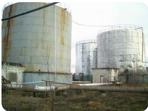
Бак горячего водоснабжения
