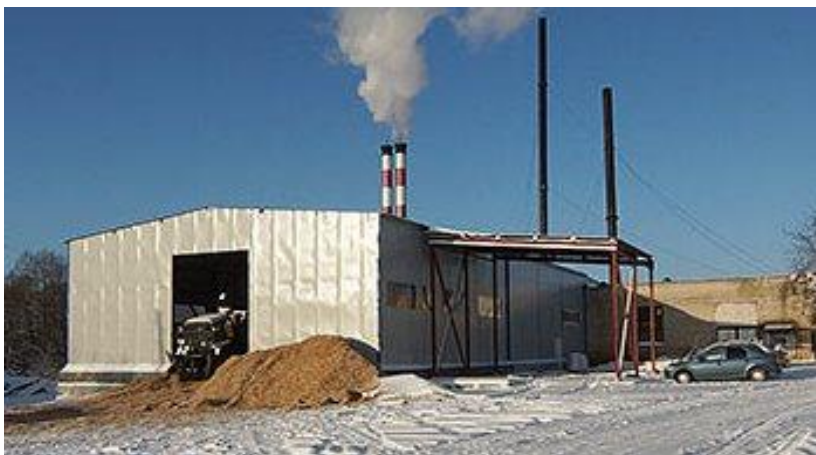
Котельная п. Нерехта
