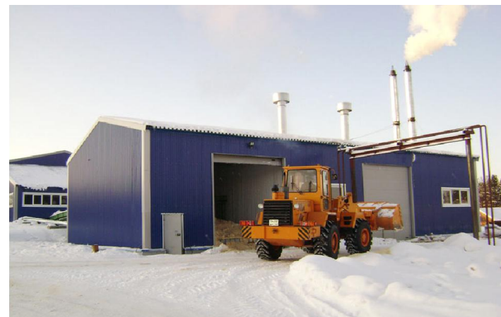
Котельная п. Шевинская
