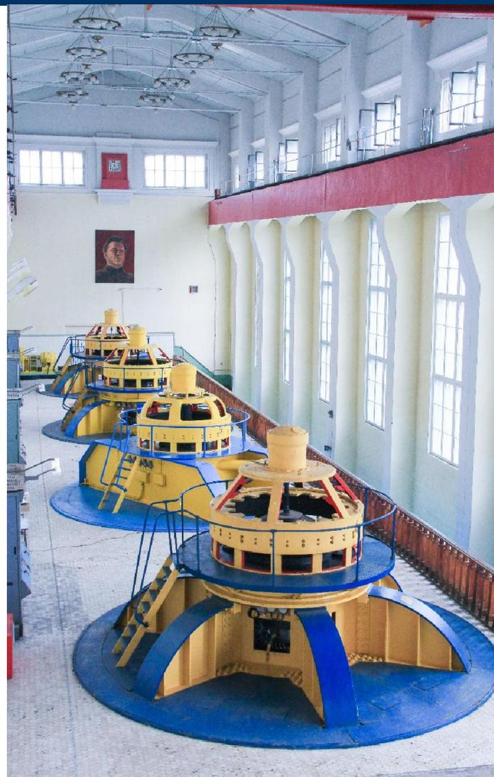
В 2014 году завершился проект модернизации Иовской ГЭС. В качестве основного направления модернизации были определены замена рабочего колеса с пропеллерного на поворотное-лопастное и применение более высокого давления в системе регулирования турбин.
