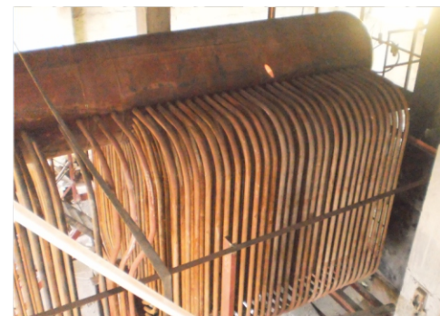
ДКВр-10-13 ГМ (замена ячейки)
