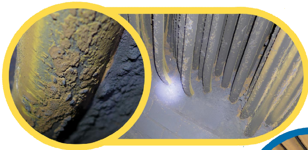
Фото 1: экранные трубы после эксплуатации без присадки МГМ-АТ-1
