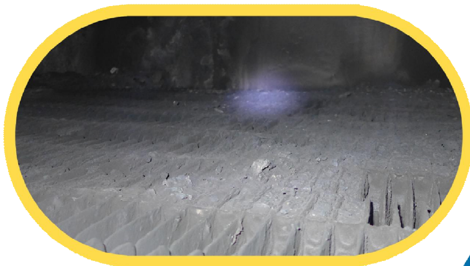
Фото 3: экономайзер без использования присадки МГМ-АТ-1
